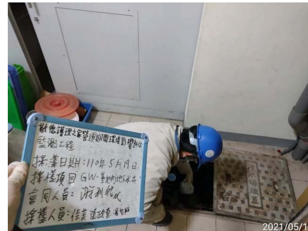
(基地內地下水井)
