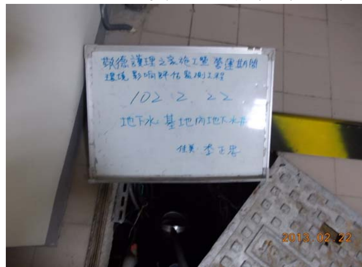
(基地內地下水井)
