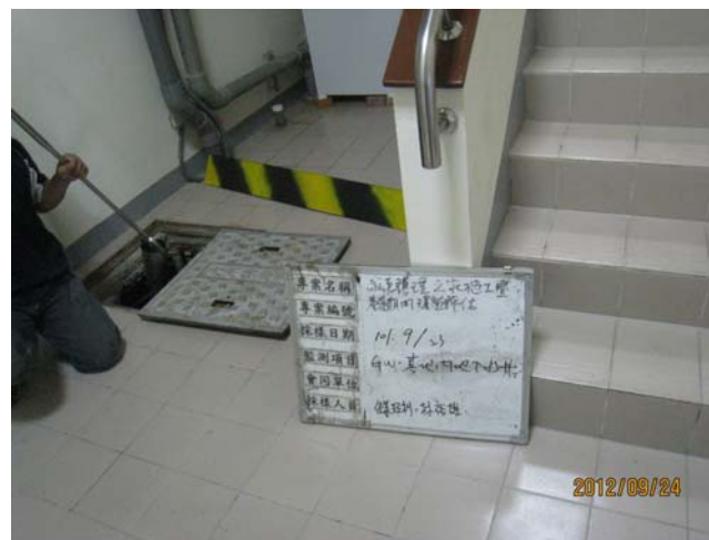
(基地內地下水井)
