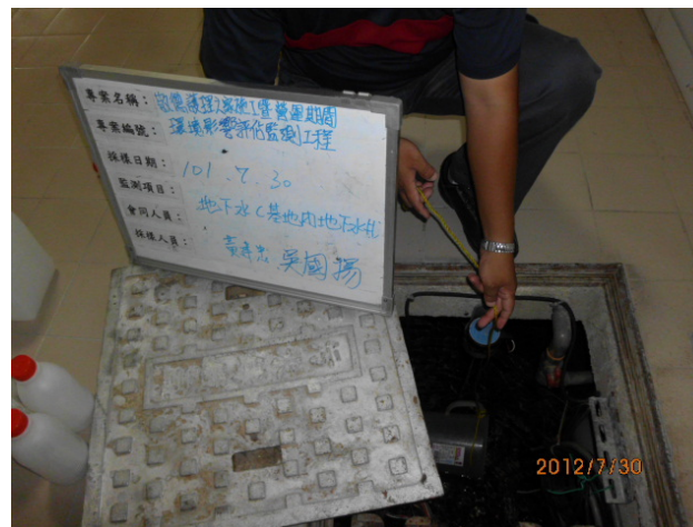
(基地內地下水井)
