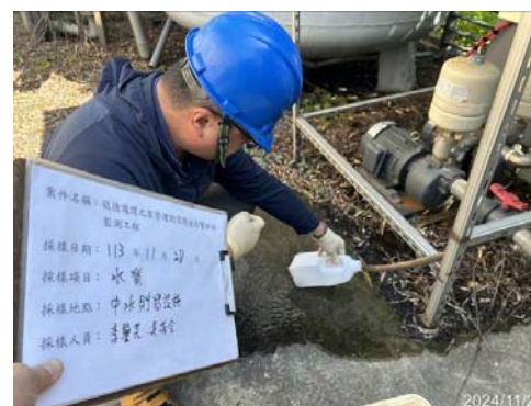
(中水貯留設施)
