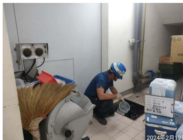
(基地內地下水井)
