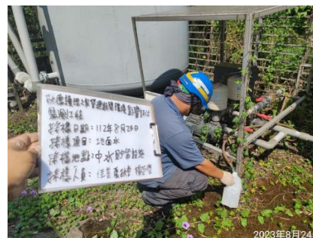
(中水貯留設施)
