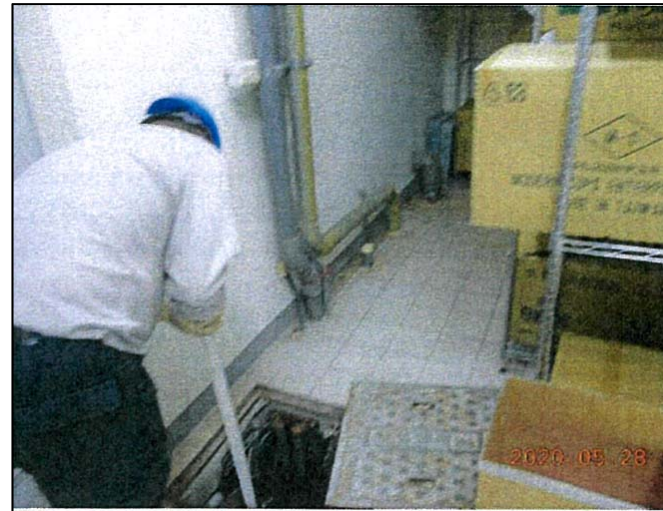
(基地內地下水井)
