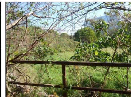
(沉砂池排水口)
