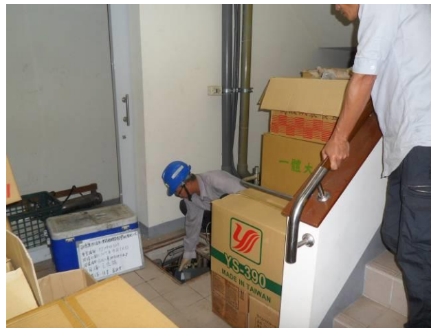
(基地內地下水井)
