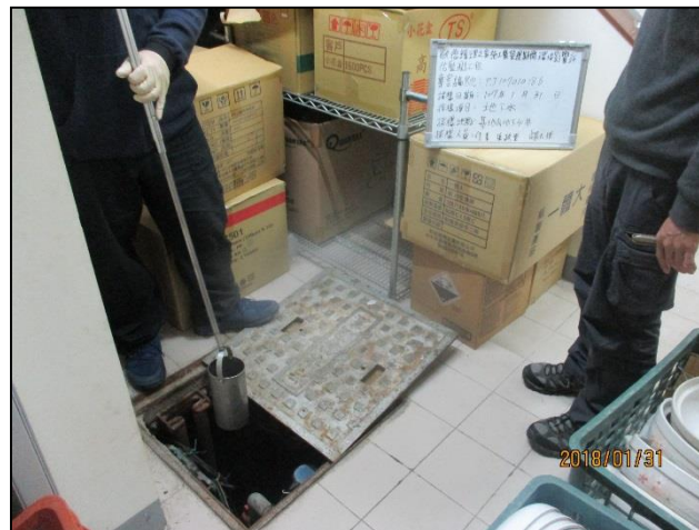
(基地內地下水井)
