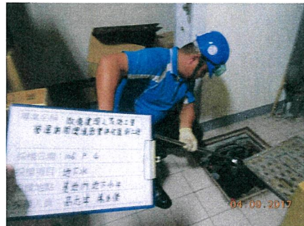
( 基地內地下水井 )
