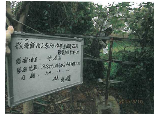
(沉砂池排水口及承受水體下游)
