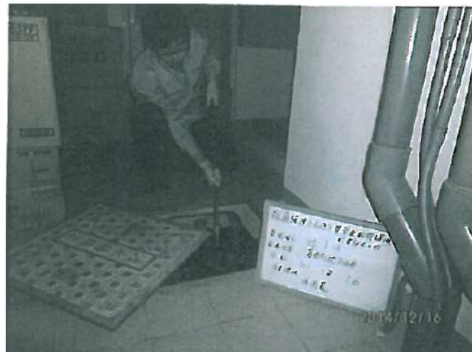
(基地內地下水井)
