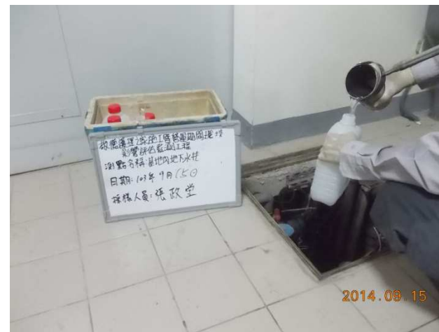
(基地內地下水井)
