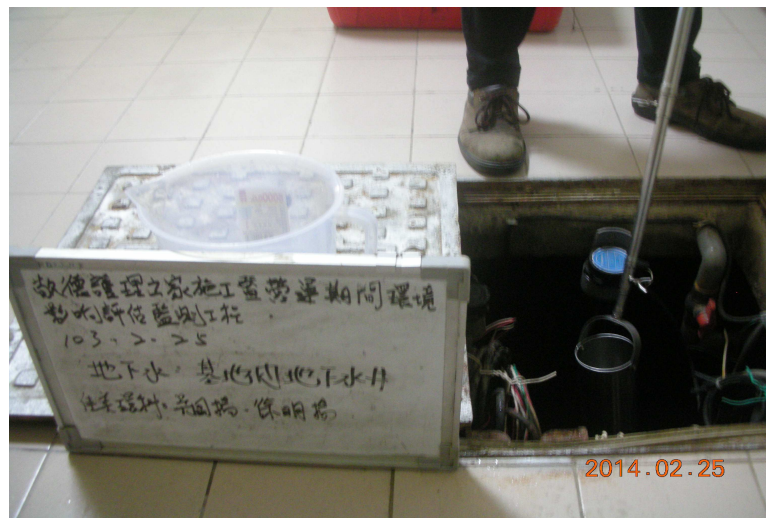
(基地內地下水井)
