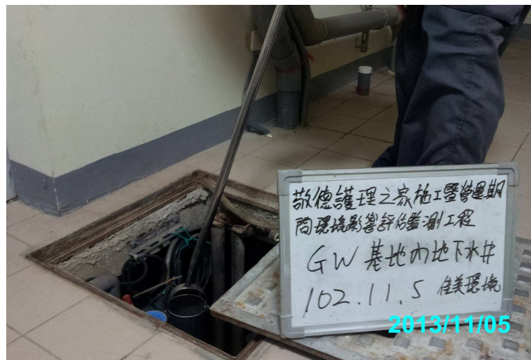
(基地內地下水井)
