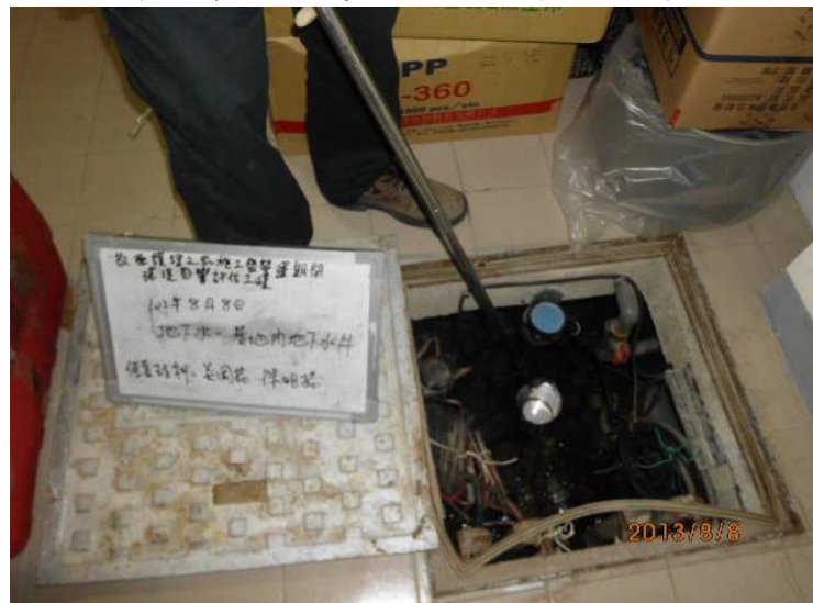
(基地內地下水井)
