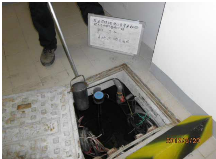
(基地內地下水井)
